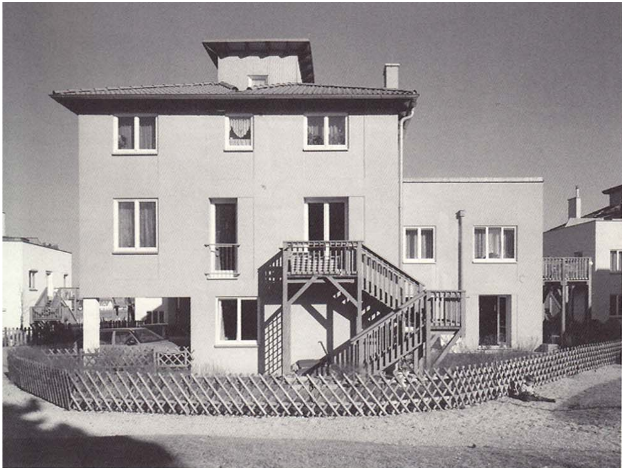
Wohnhaus Brunnergasse Hermann Czech 1990-94
